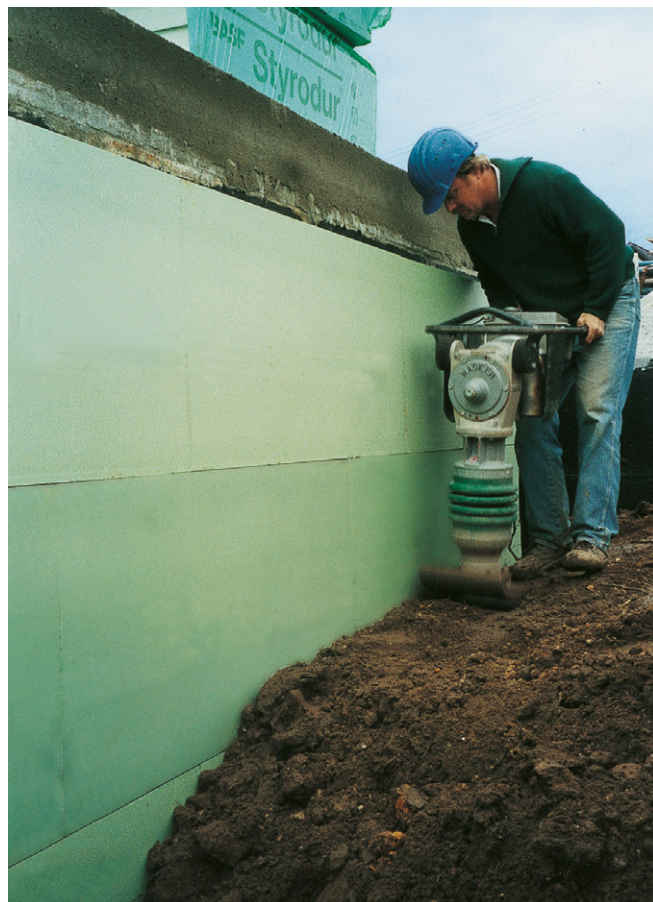
Abb. 18: Lagenweise Verfüllung der Baugrube und mechanische Verdichtung
