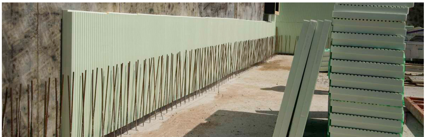
Abb. 4: Verlegung von Styrodur Hybrid an der Innenseite der Schalung
