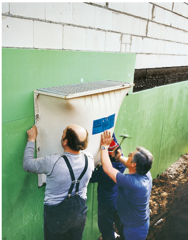
Abb. 13: Anbringen eines Lichtschachtes
