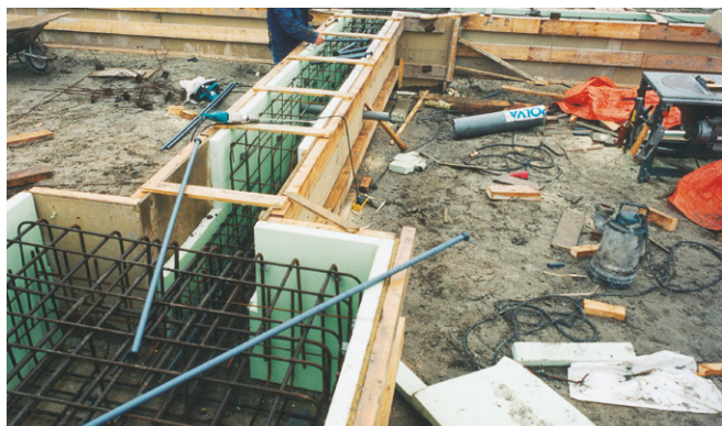
Abb. 16: Schalung mit Styrodur Hybrid
