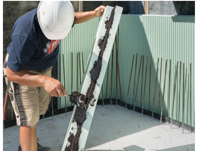
Abb. 6: Verspachteln der Plattenränder gegen drückendes Wasser
